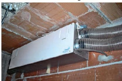
Figura 6 – Deumidificatore a soffitto (si vedono gli sportelli di accesso per la manutenzione)
